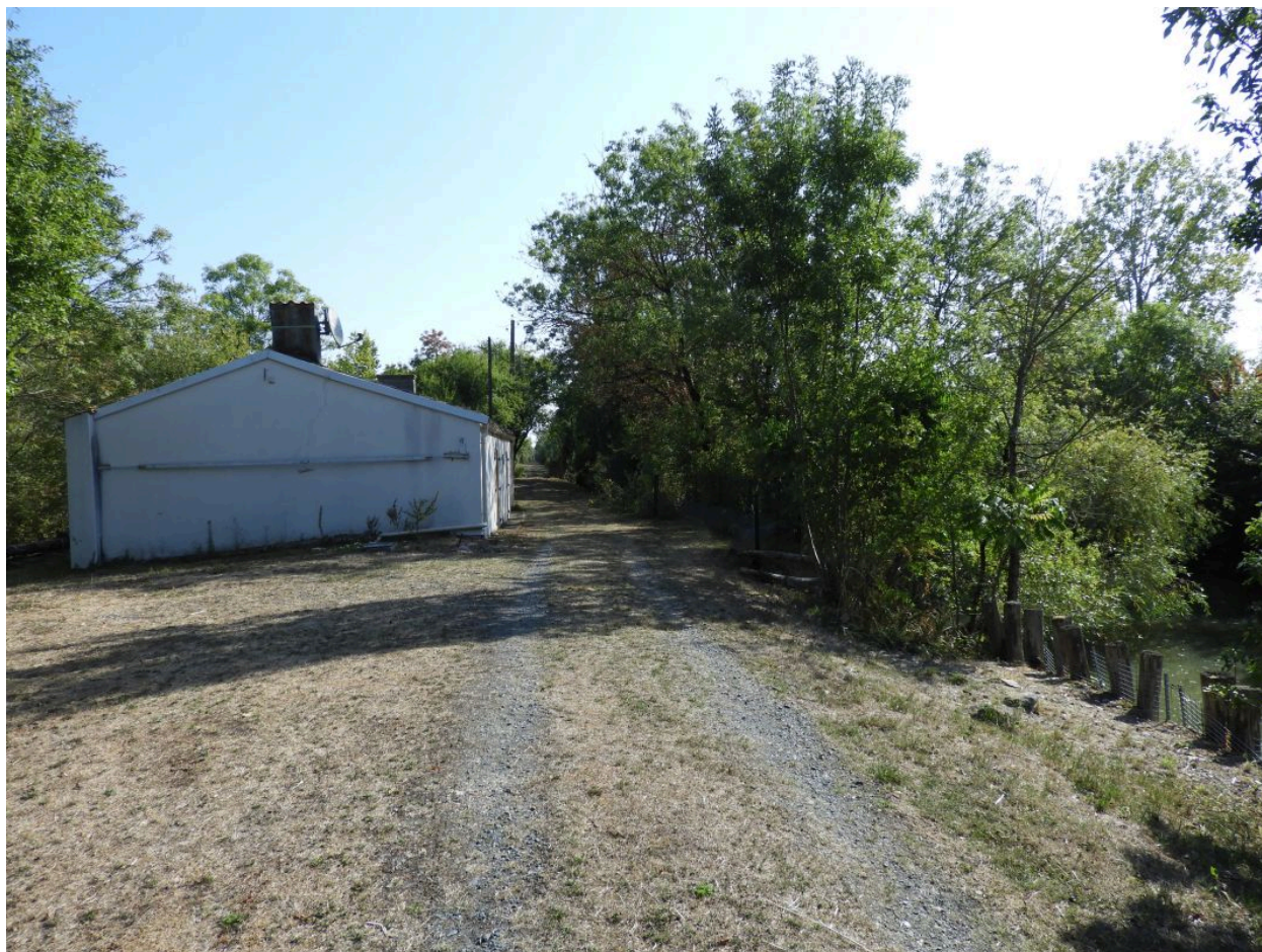
La hutte vue depuis l'ouest.
