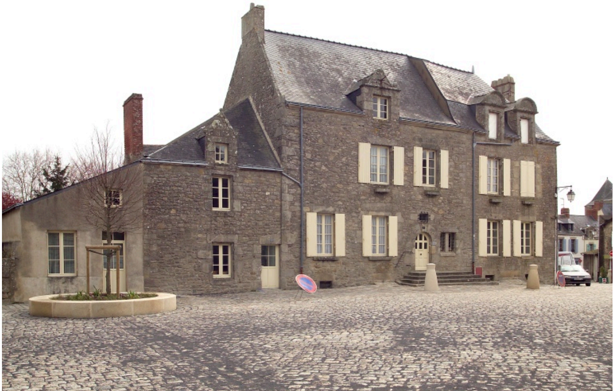
Vue de la place du Vieux Marché. Le n° 5 est au centre de l'image.
