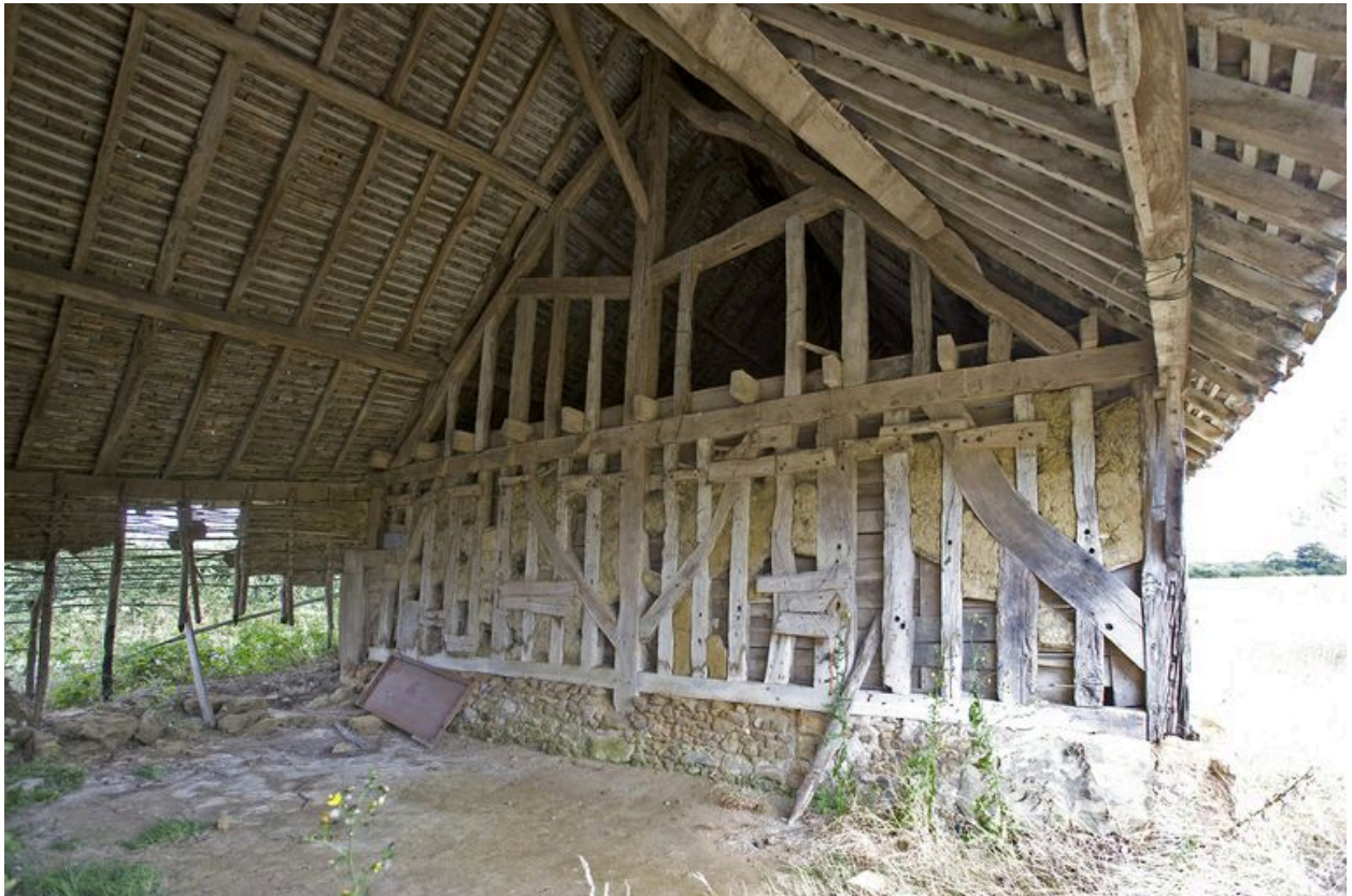
Remise, vue intérieure.
