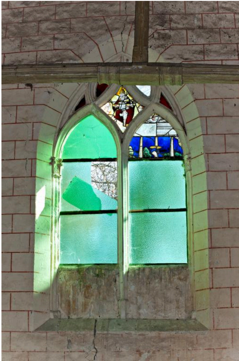
Chapelle sud-est : baie.
