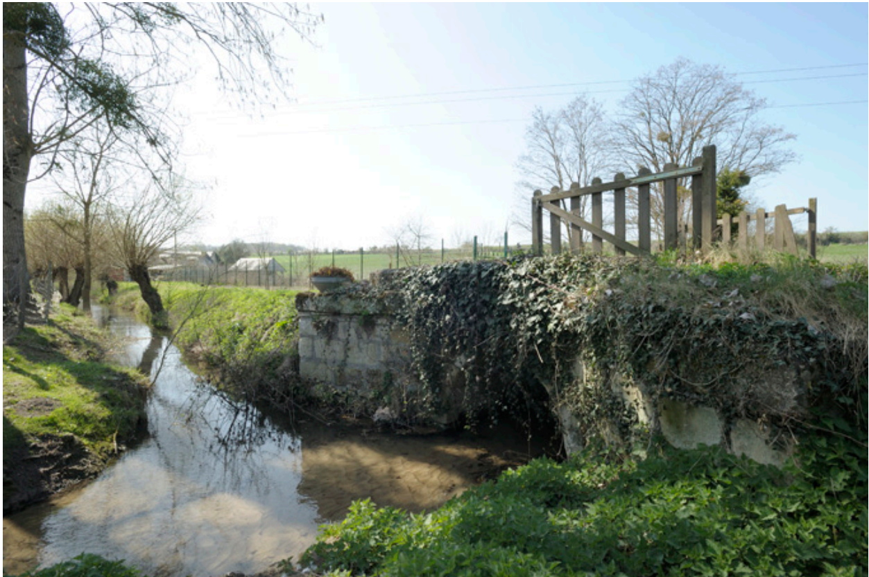
Ponceau à la confluence de l'Arceau et du bief, en aval du moulin.
