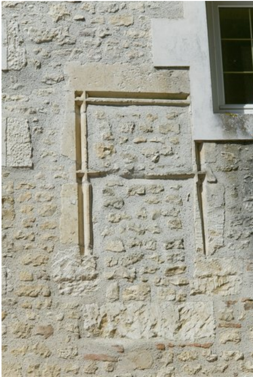
Vestiges de demi-croisée, à l'étage de la façade est de la maison 3, rue des Chanoines.
