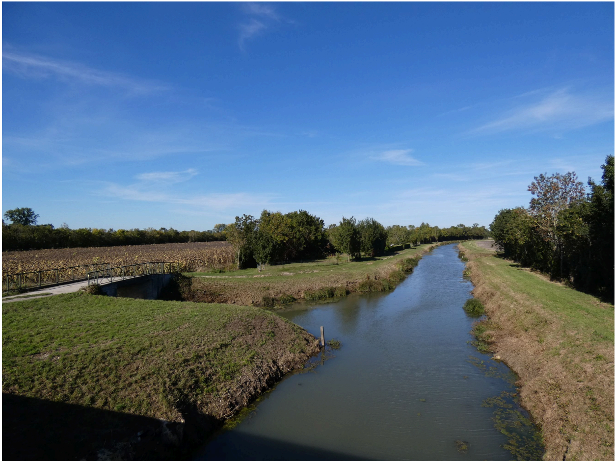
Le canal au pont de la Petite Bernegoue, en direction de l'amont, vers le nord.
