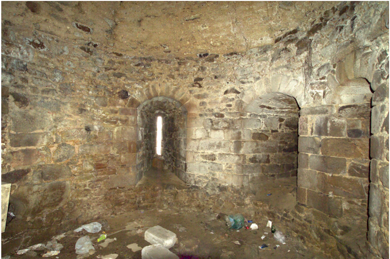
Salle au rez-de-chaussée.
