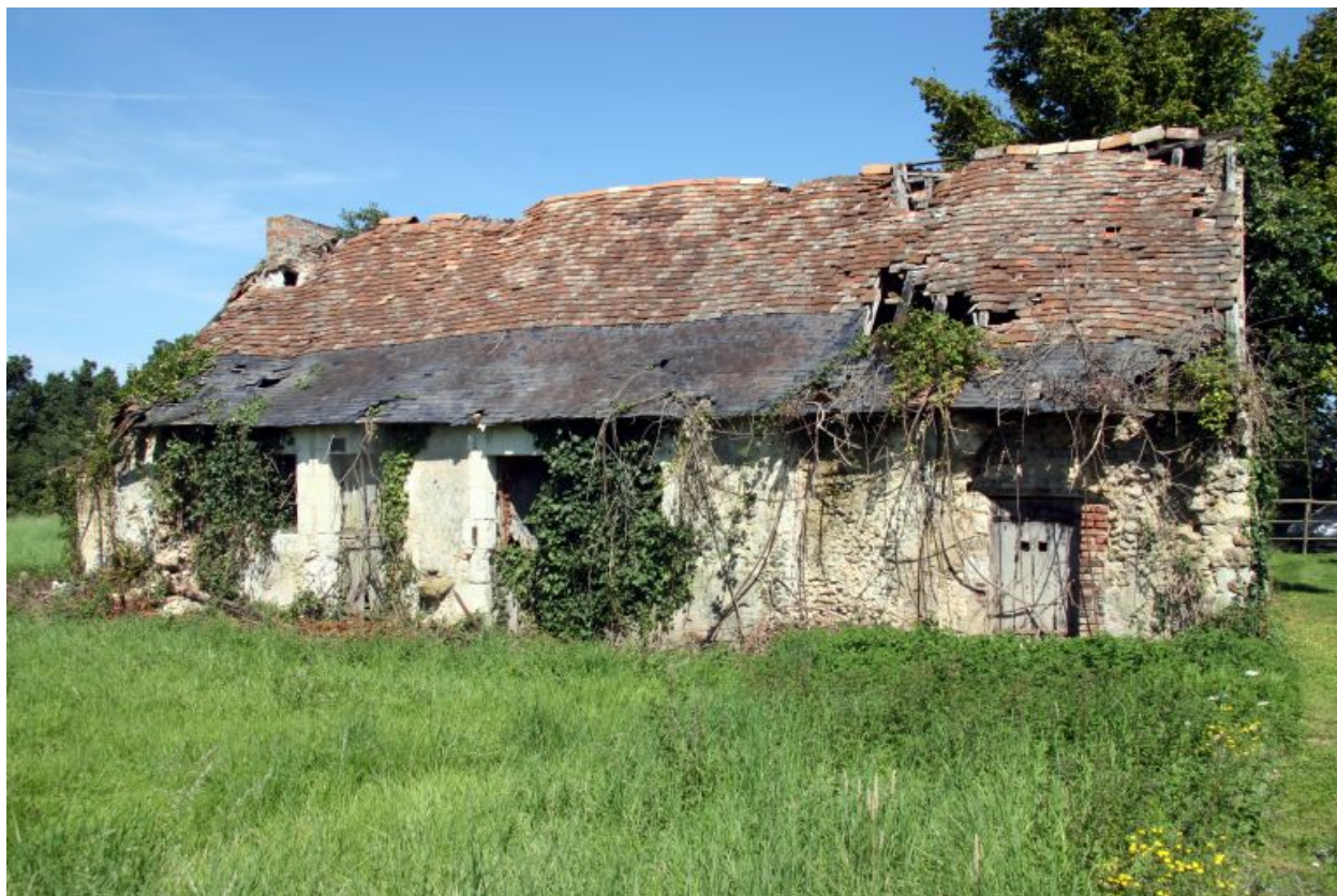
La maison : façade antérieure sur cour.
