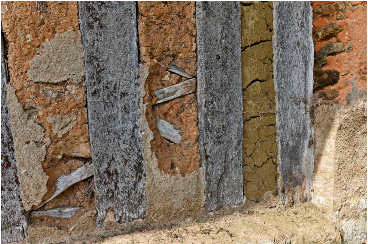
Elévation postérieure : détail de la mise en oeuvre du pan-de-bois.
