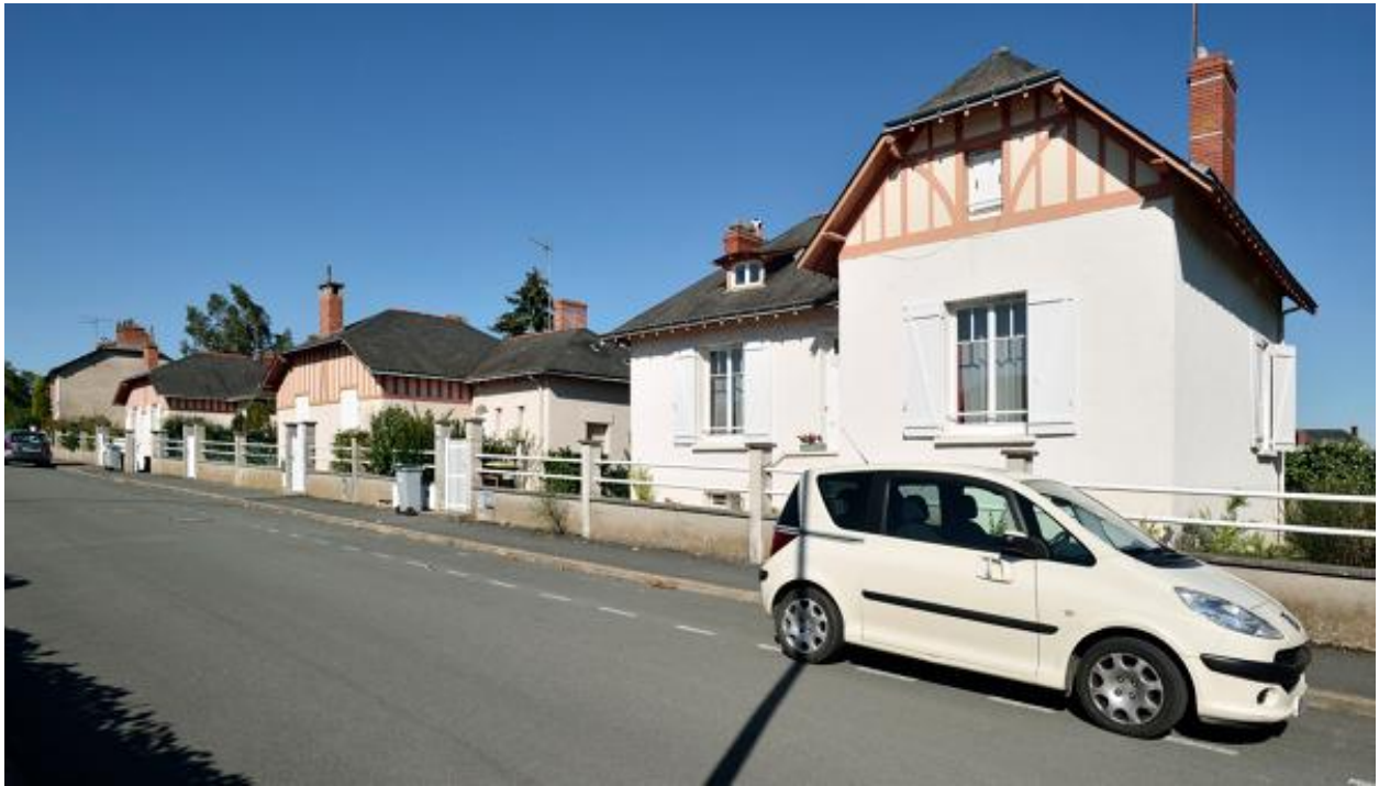
8, 10 et 12-14 rue de Bel-Air. Vue d'ensemble depuis la rue.
