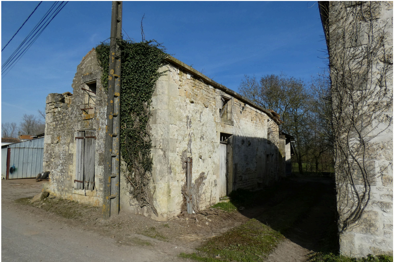
Les vestiges de la ferme vus depuis le sud-ouest.
