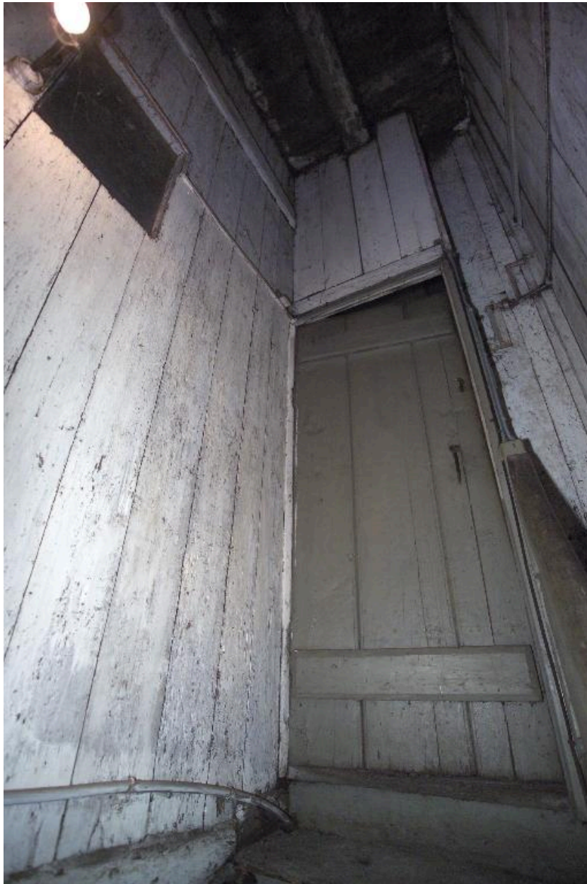
La porte d'accès au deuxième étage vue depuis l'escalier.
