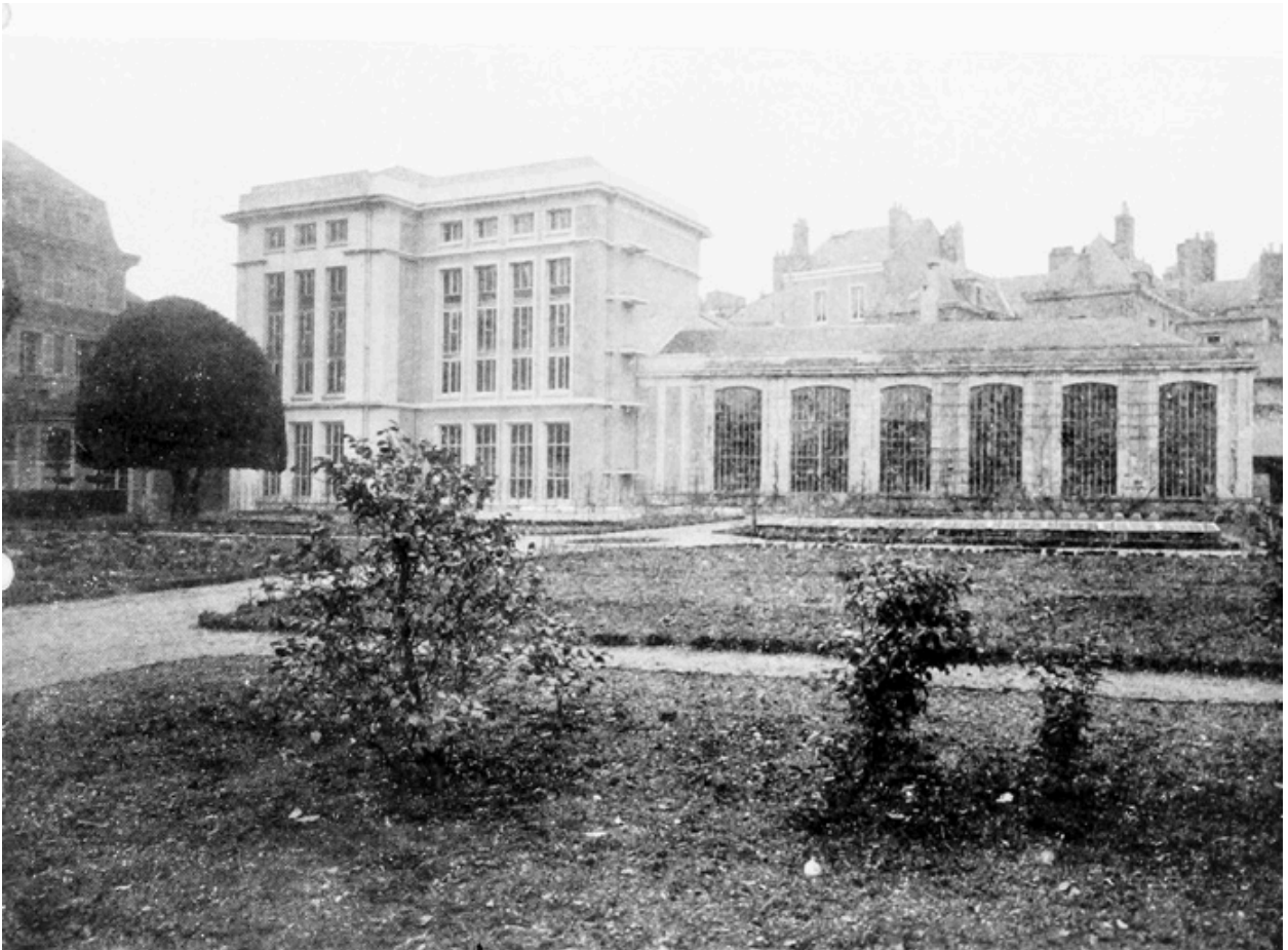
Les archives et l'orangerie, façades sud, sur le jardin-potager, fotogr., [1959]. In : Administrer, 1959.
