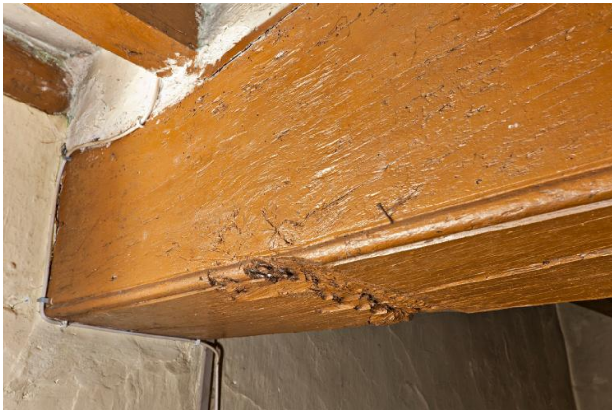
Chambre à feu ouest : détail de la poutre moulurée.
