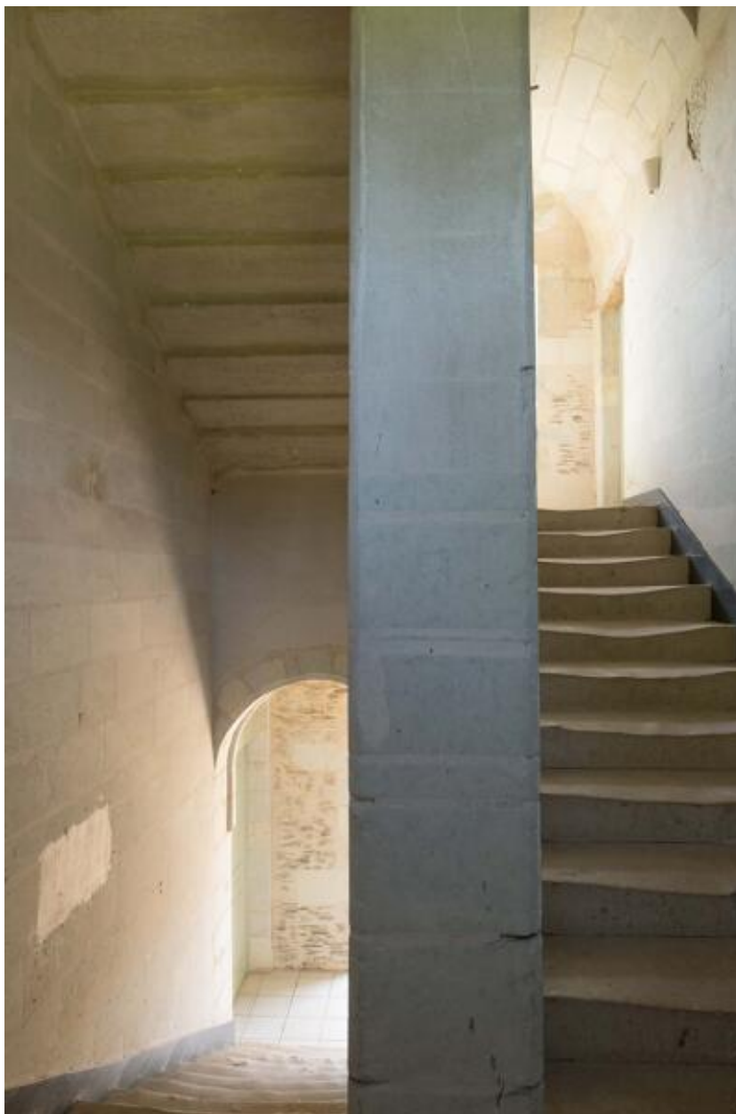
Détail de l'escalier intérieur depuis le premier repos.
