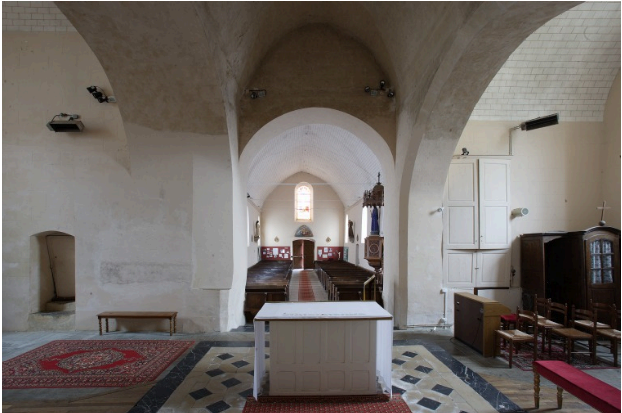
Vue intérieure : la nef et une partie du chœur et des chapelles vues depuis le chœur.
