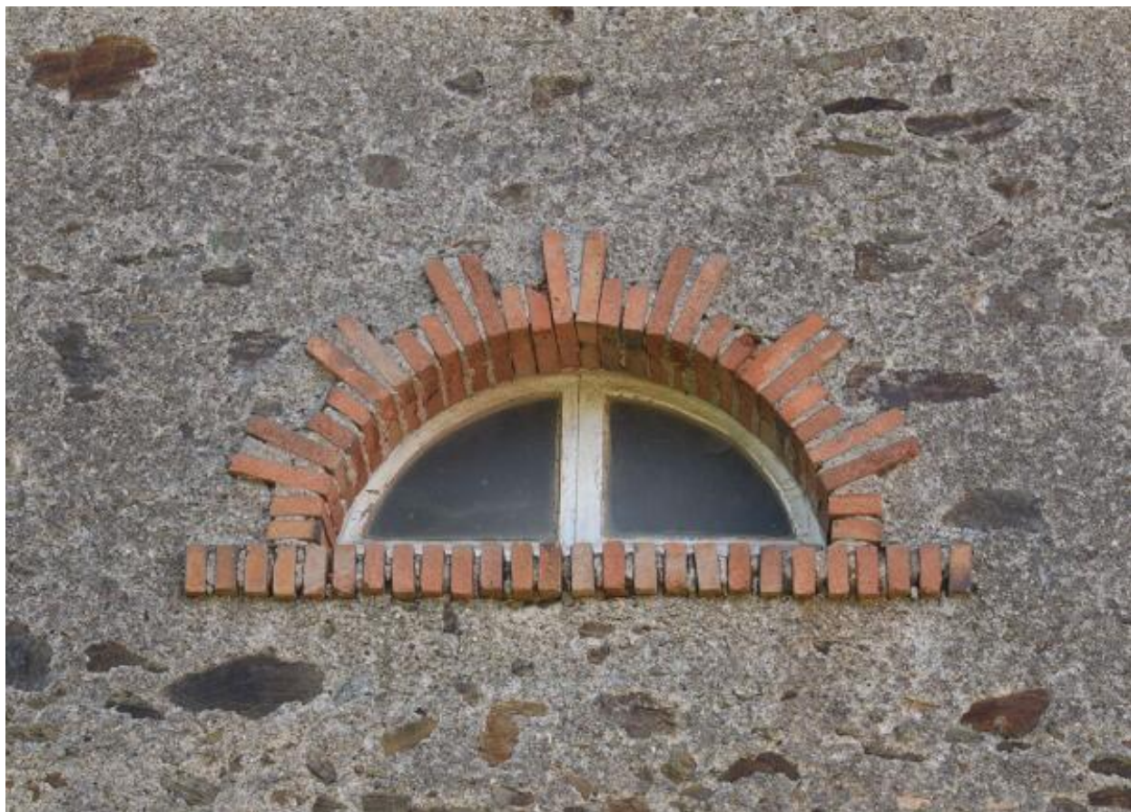
Façade sud. Détail d'un jour.
