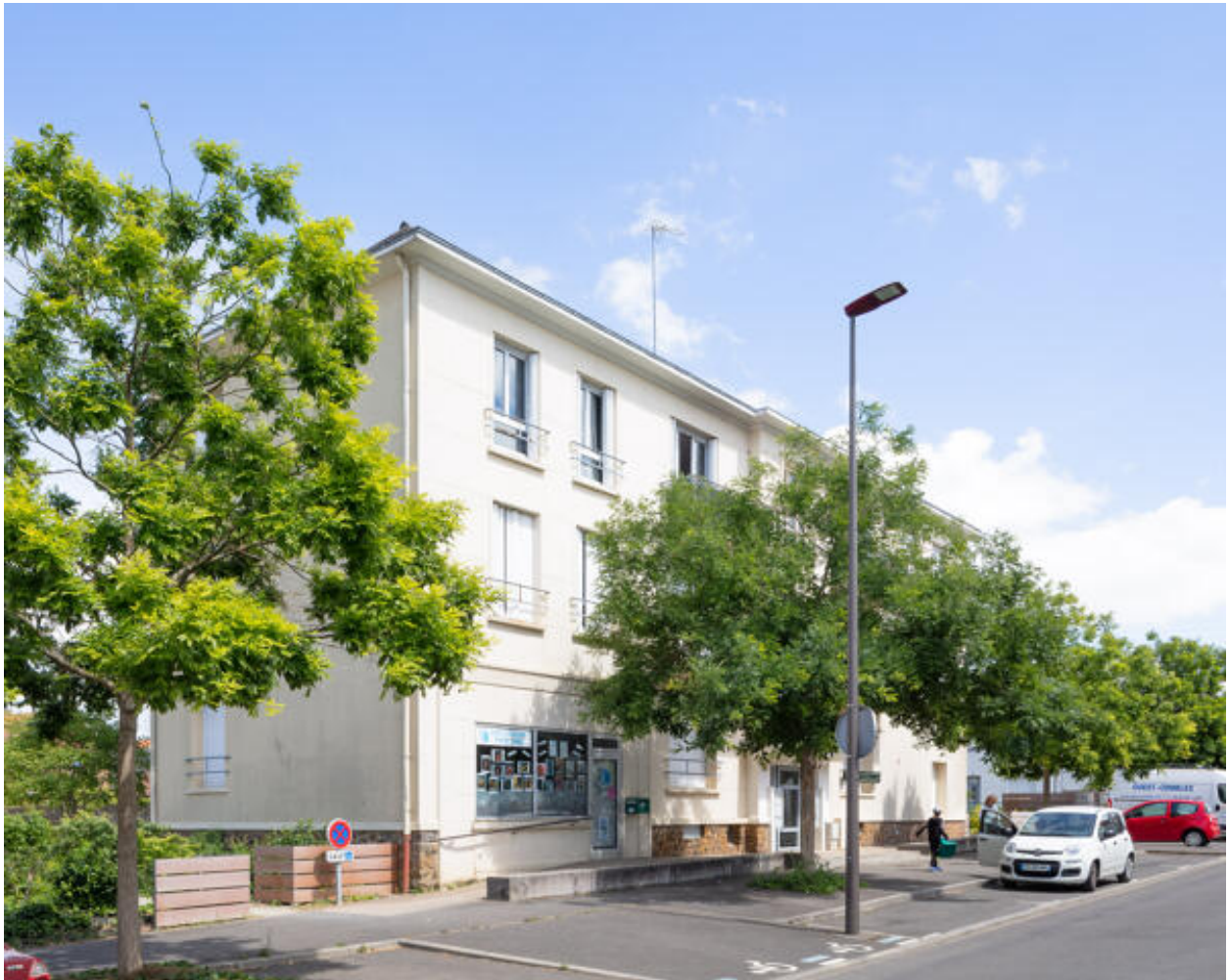
Vue de l'immeuble F rue Raymond-Persignan.
