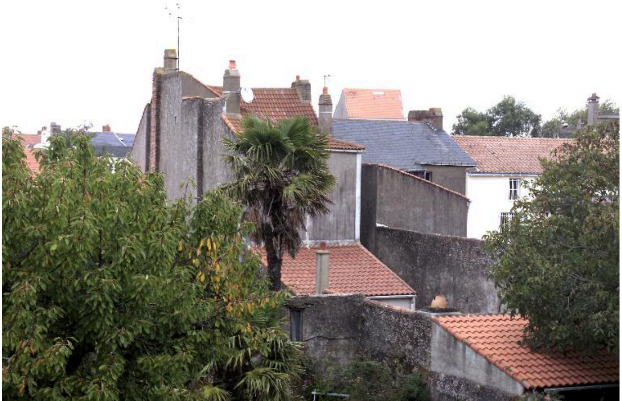
Vue d'ensemble des façades postérieures des maisons n° 11 (à gauche) et n° 9 rue du Faisan (à droite).
