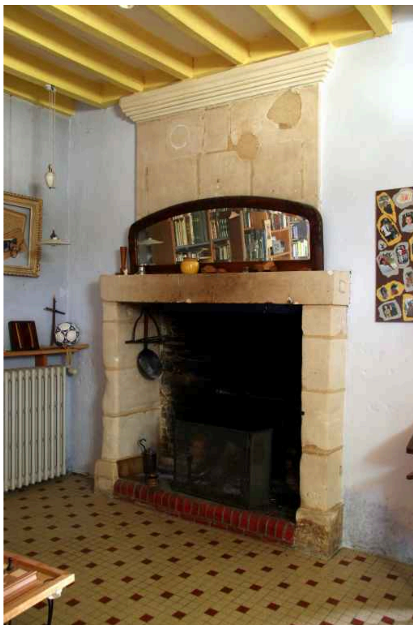
Cheminée de la salle centrale.
