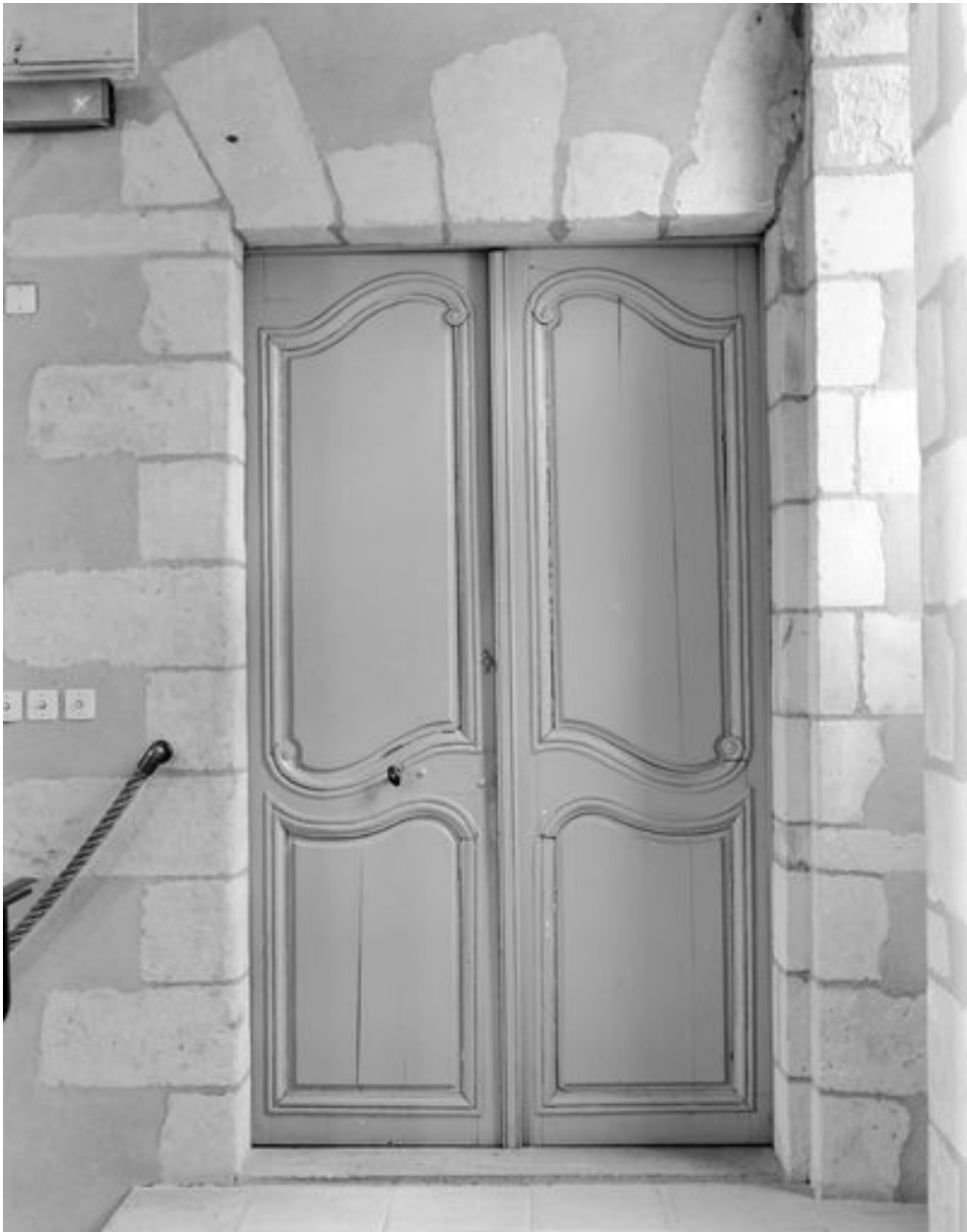
Abbaye, escalier principal entre réfectoire et cuisine, palier du premier étage : porte ouest.
