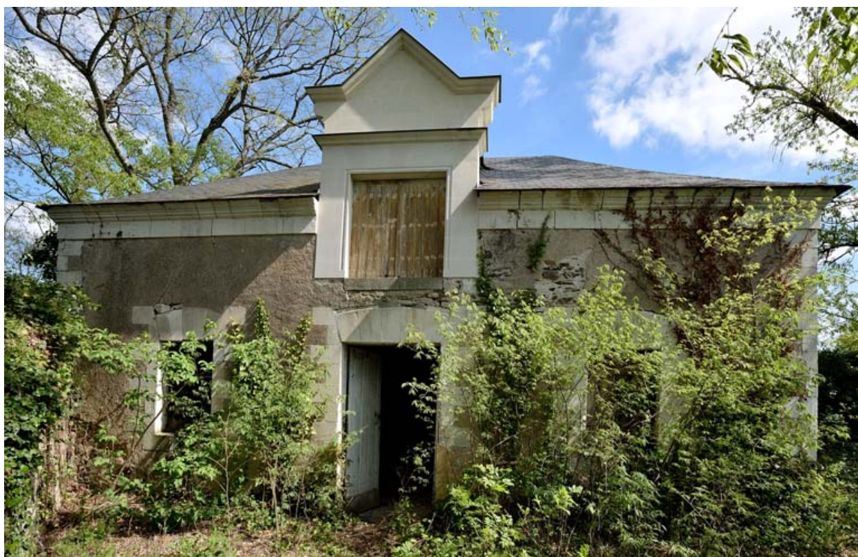
Mantelon. Bâtiment de communs.
