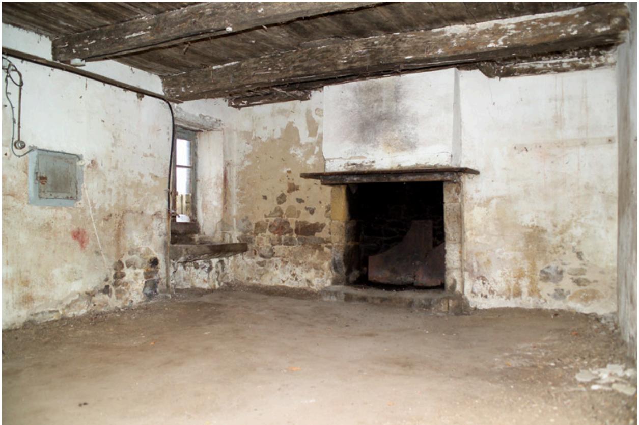
Aile sud, pièce orientale, rez-de-chaussée, cheminée orientale.
