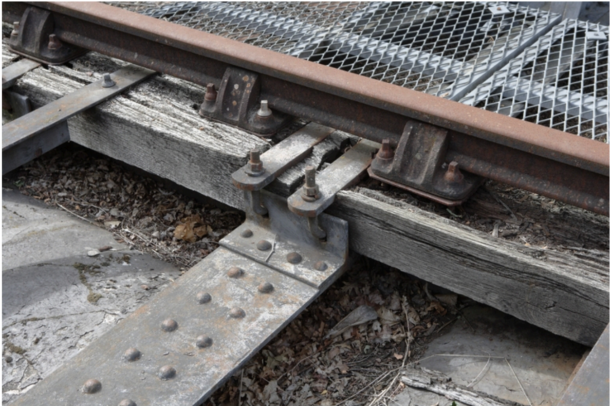
Détail des fixations des rails.
