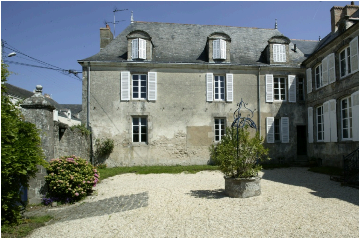
Hôtel de Kerhué vu depuis la cour, vers l'Ouest.
