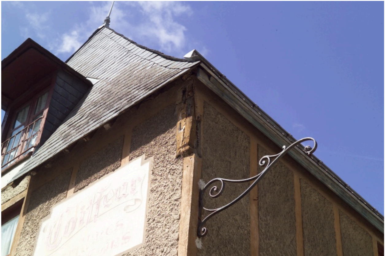
Détail de la partie supérieure de l'angle nord-est.
