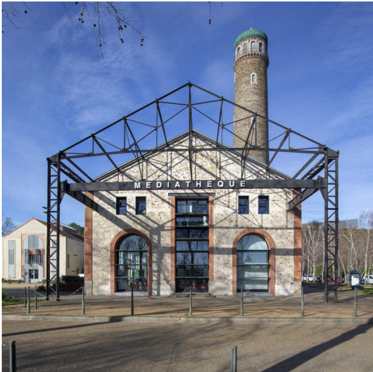
Façade antérieure de l'ancien atelier des plombs ouvrés.
