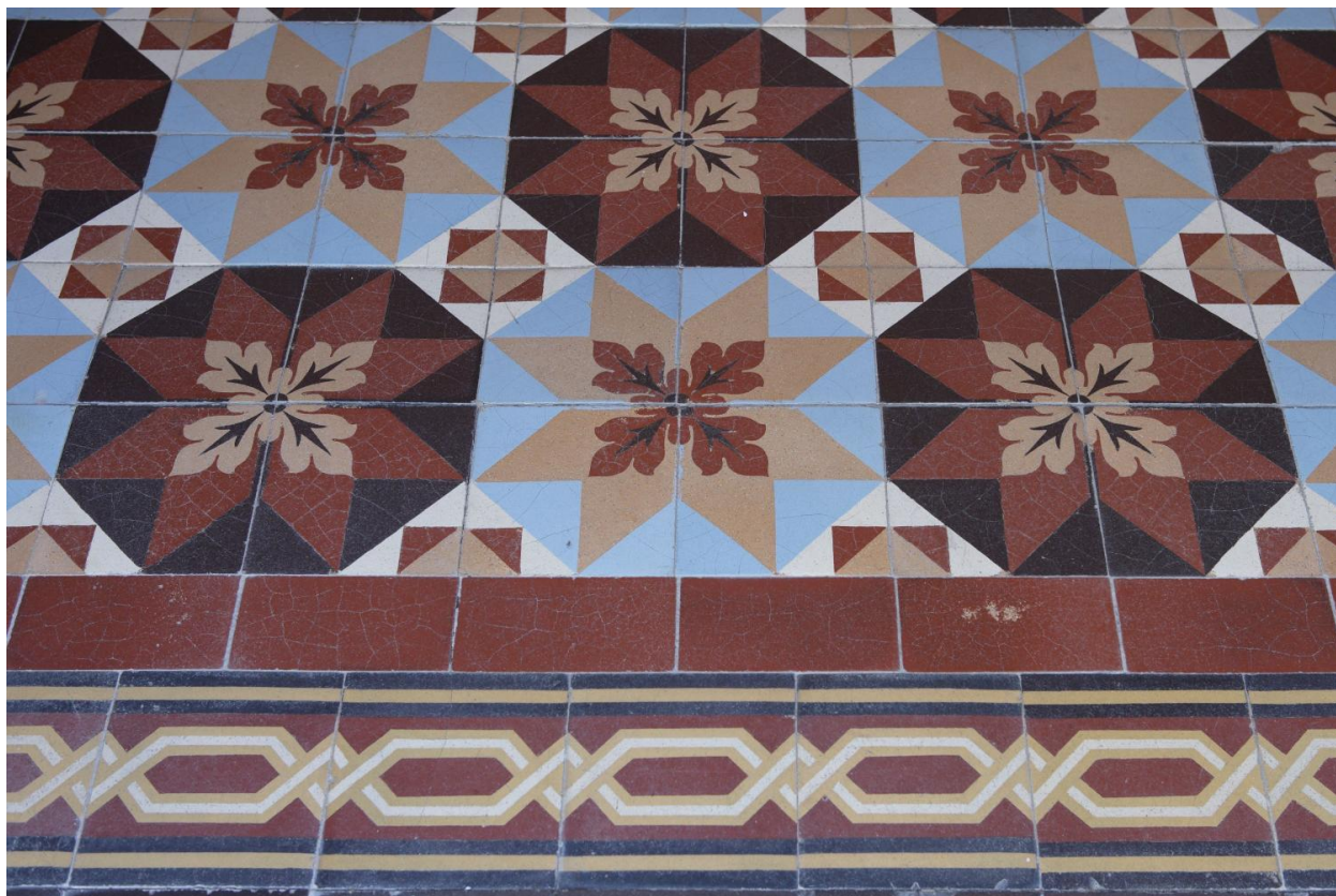
Détail du carrelage dans le hall d'entrée.
