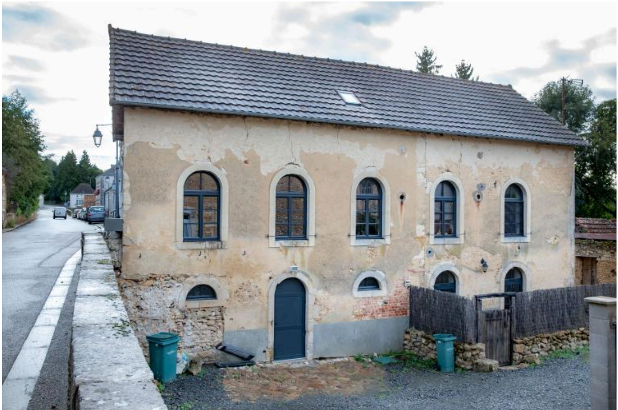
Le mur gouttereau ouest.
