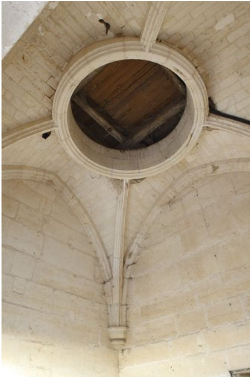
Vue de la voûte du troisième étage du massif occidental.
