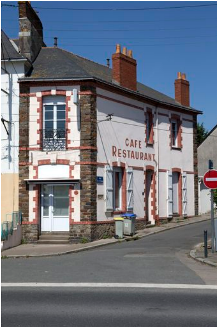
Angle rue de la Pompe et Route de Roche-Maurice.
