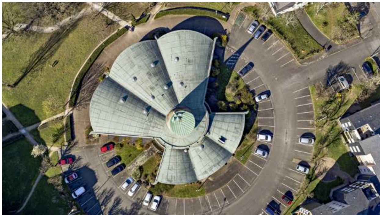
Vue aérienne de l'église du Christ-Sauveur depuis le sud-est.
