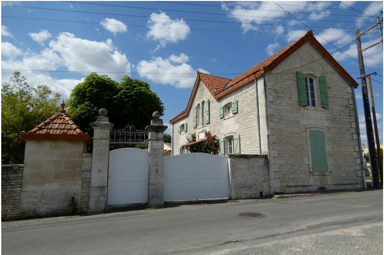
La maison vue depuis le sud-est.
