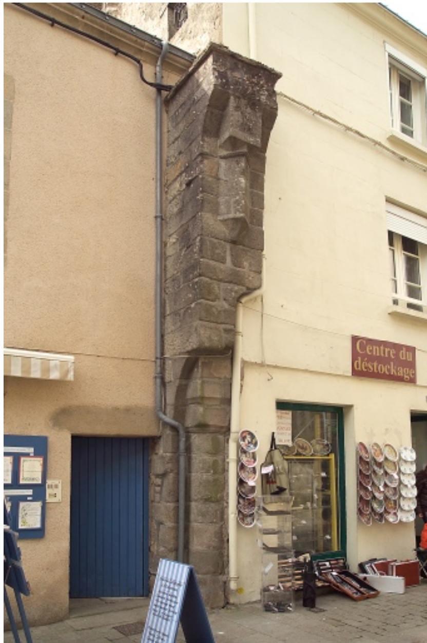
Vue du mur gouttereau à encorbellement dans la rue de Saillé.
