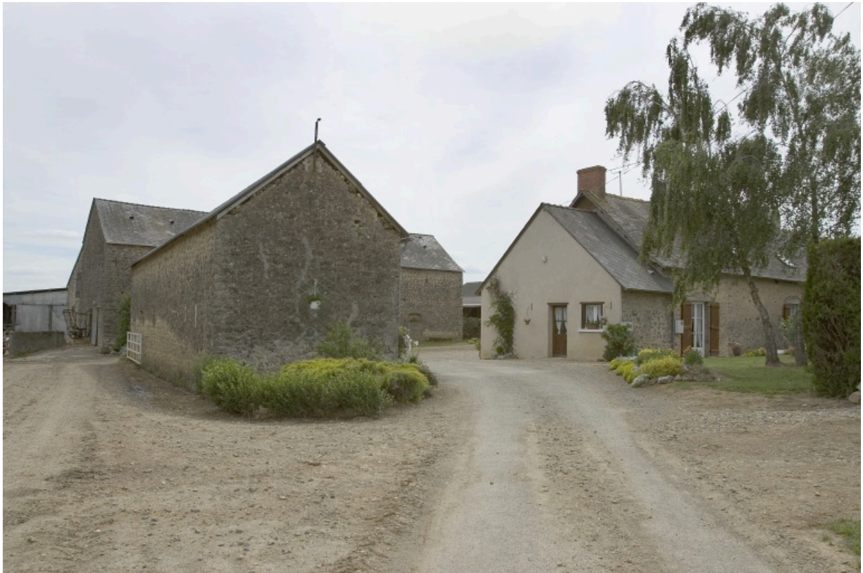
Vue d'ensemble de la ferme sud depuis le chemin d'accès au nord : la porcherie, l'étable, le logis.
