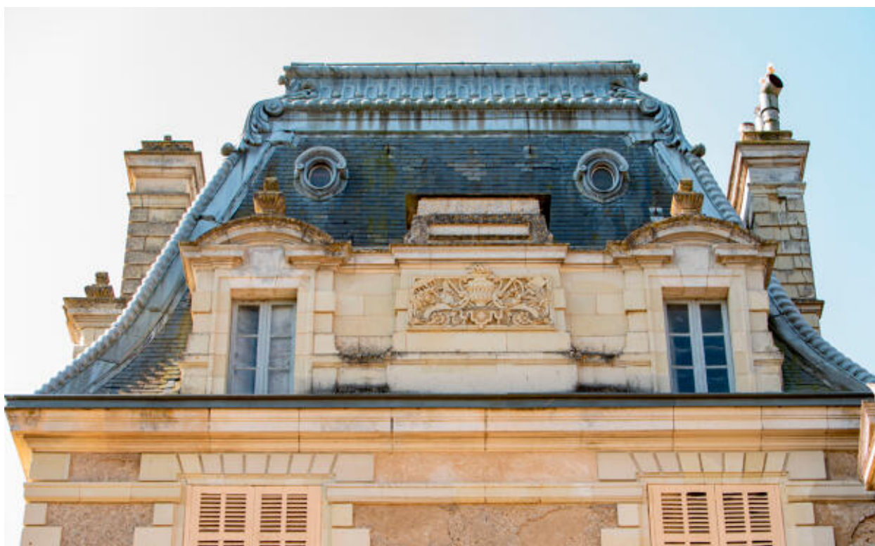
Le pavillon sud-est, détail du comble.
