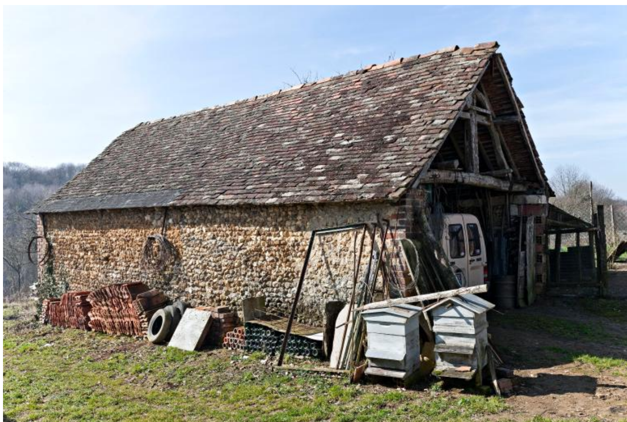
Hangar agricole (ferme 1).
