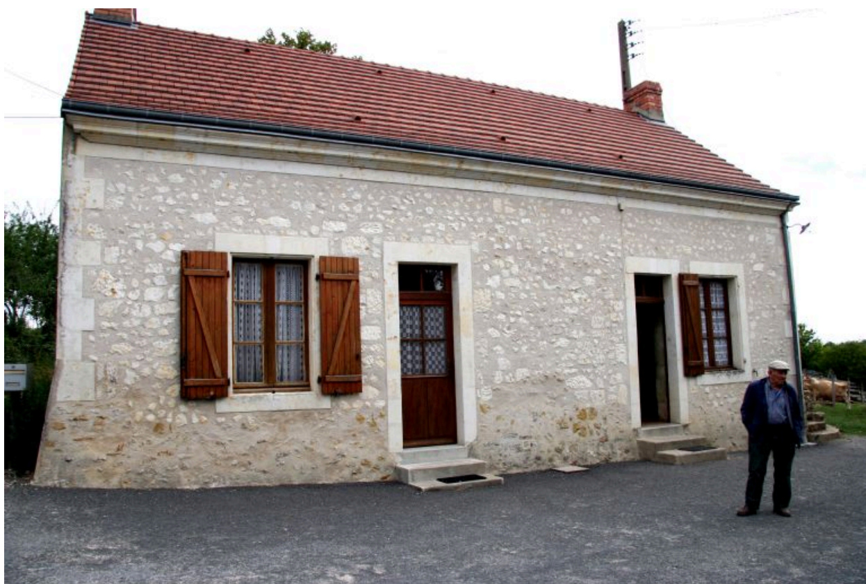
Façade antérieure sur cour.
