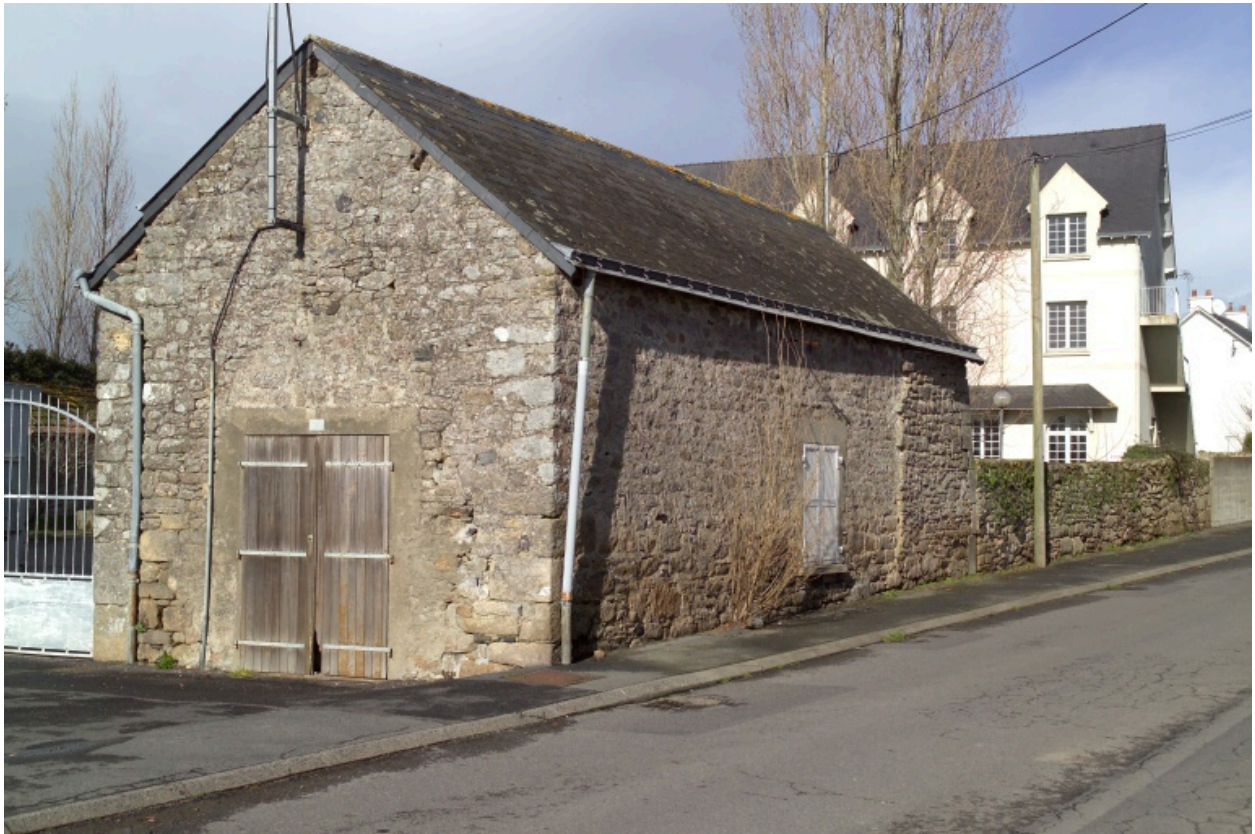
Bâtiment est. Vue depuis le sud.
