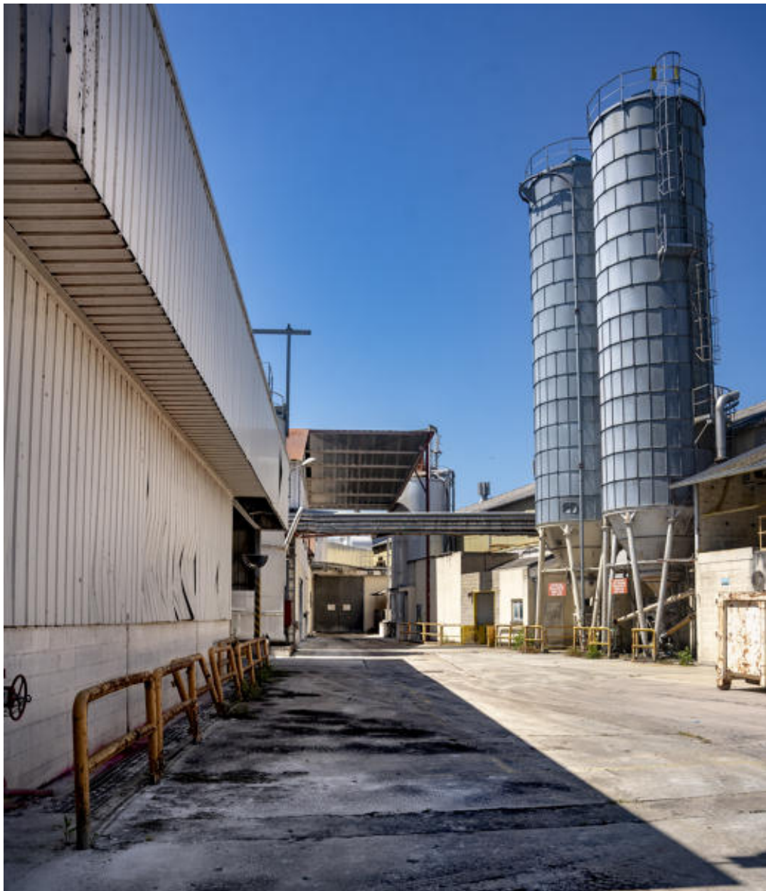
Ancienne desserte ferroviaire de l'usine (3 du plan).
