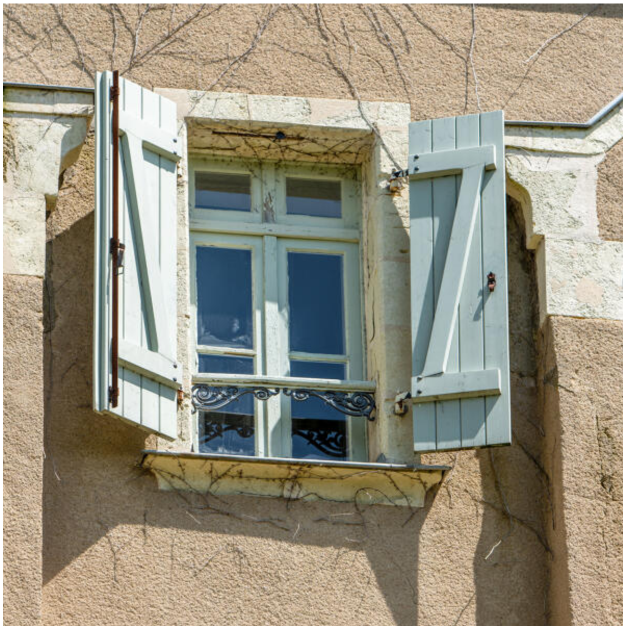
Une fenêtre du corps central.
