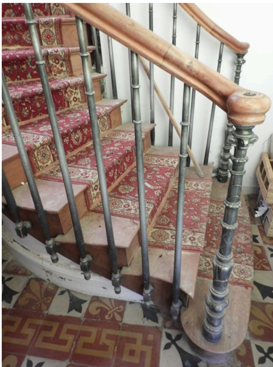
L'escalier dans l'ancienne entrée de la maison.
