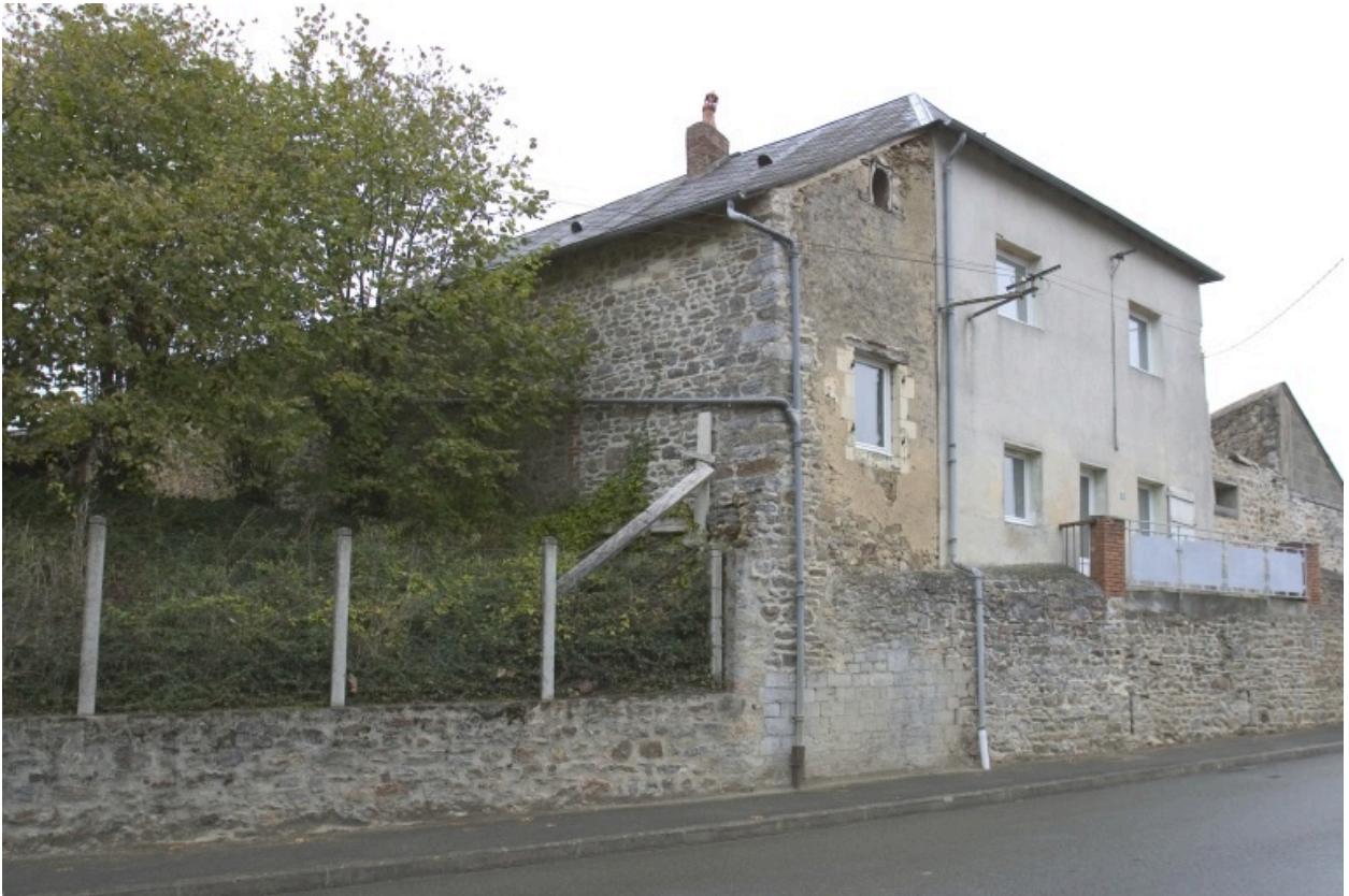
Le logement vu depuis la rue du Fief-aux-Moines, au sud-est.
