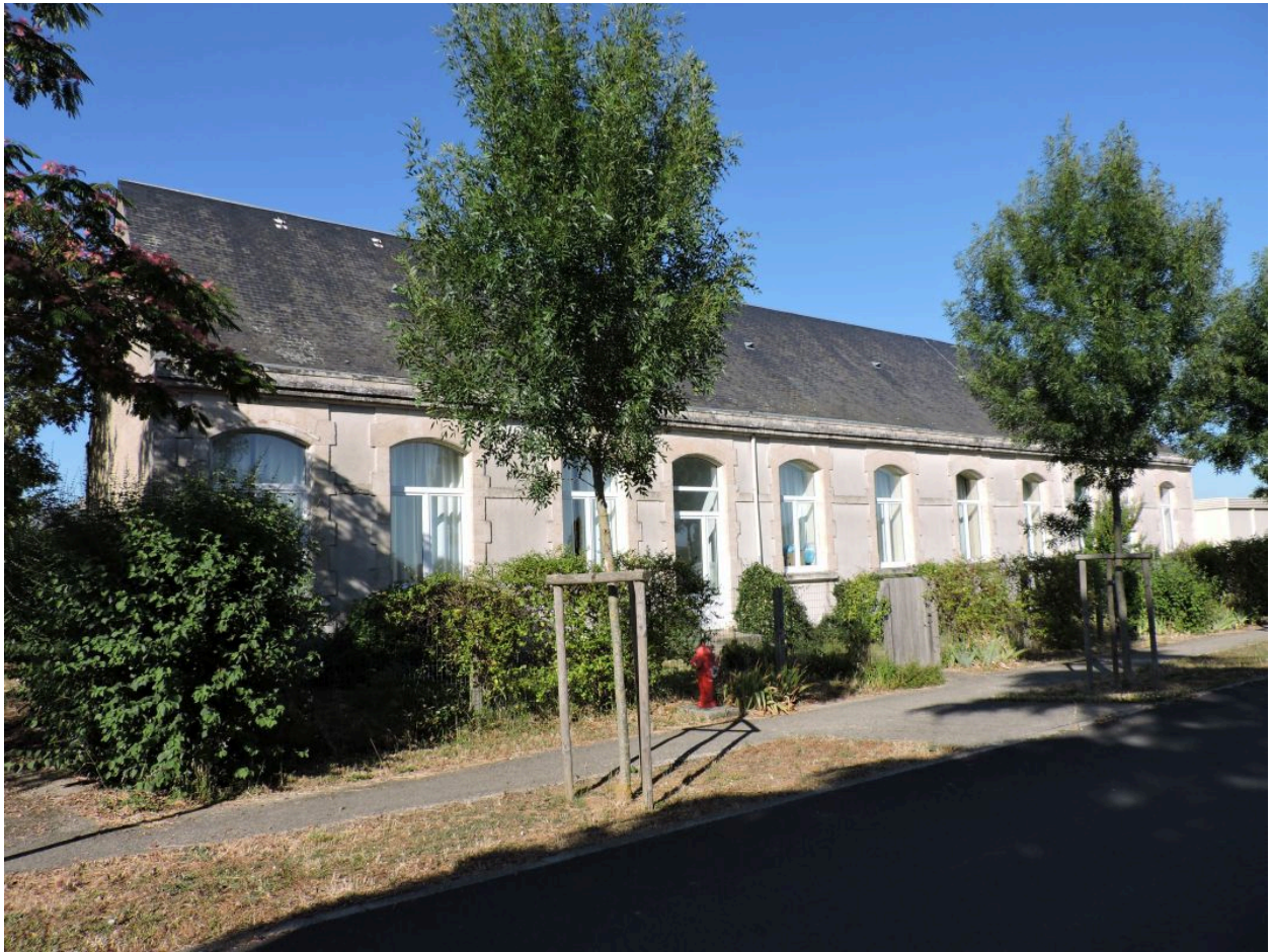
Le bâtiment de salles de classes de l'ancienne école de filles, à l'ouest, vu depuis l'ouest.
