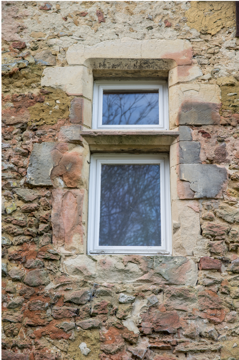
Une fenêtre chanfreinée à traverse.
