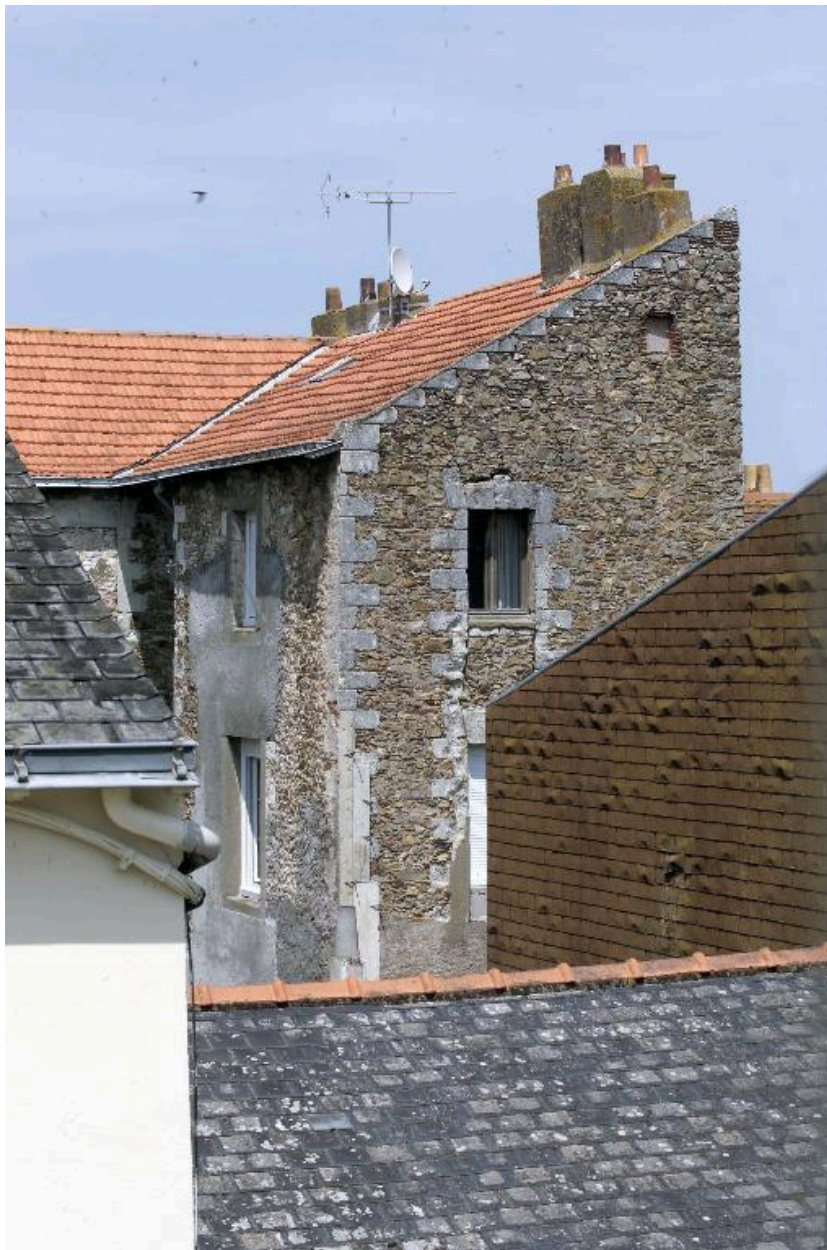
Maison, 11 quai Sadi-Carnot.
