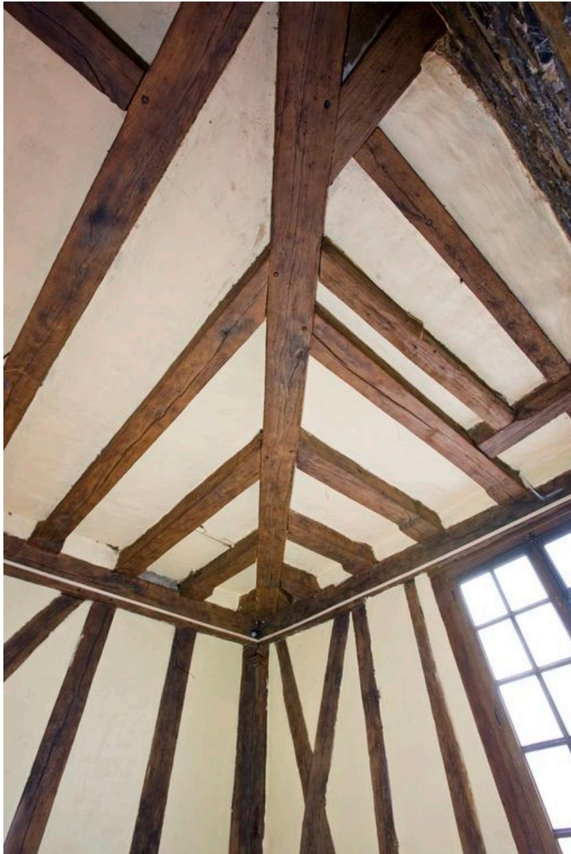
1er étage, pièce principale, angle antérieur droit : élévations et plancher du 2e étage, avec la structure de solive oblique destinée à recevoir les solives des deux élévations sur rue.
