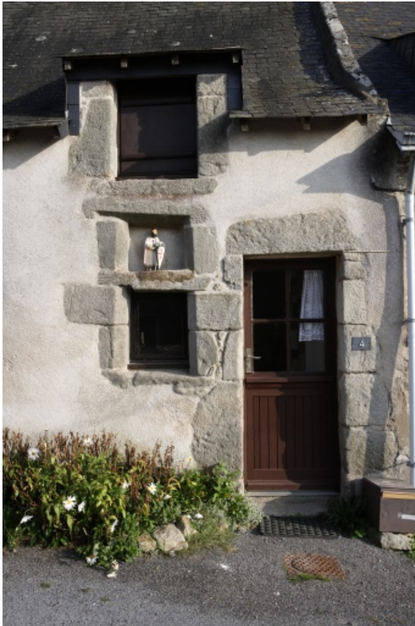
Détail de la façade du 4 rue de l'Aha.
