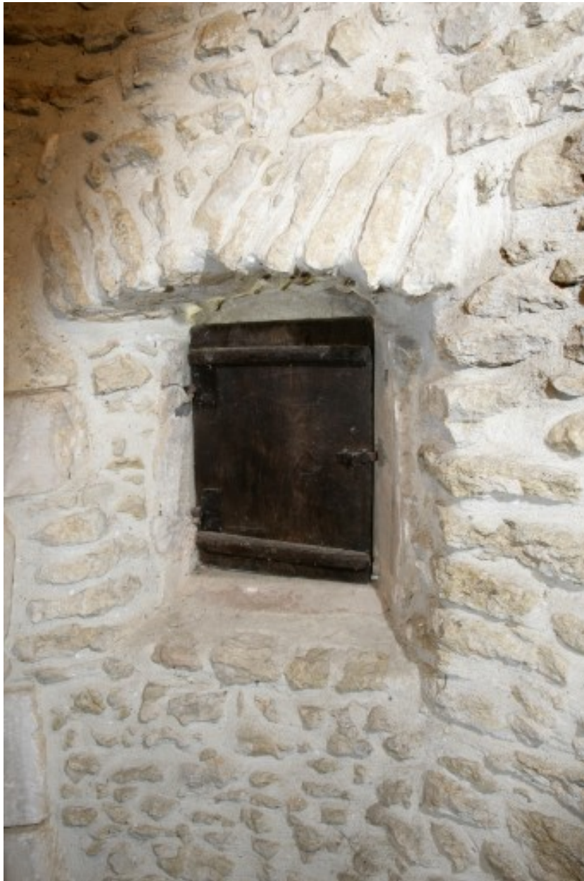
Logis, intérieur : baie de l'escalier.
